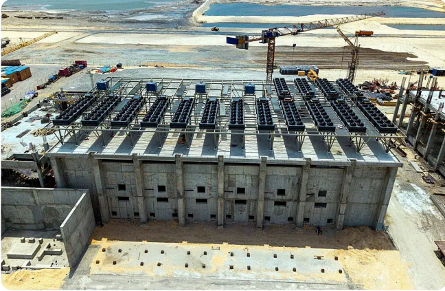
محطة طاقة تعمل بـ HFO مع رادياتيرات TECS
