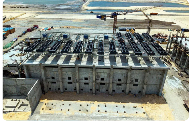
HFO-Kraftwerk mit TECS-Kühlern
