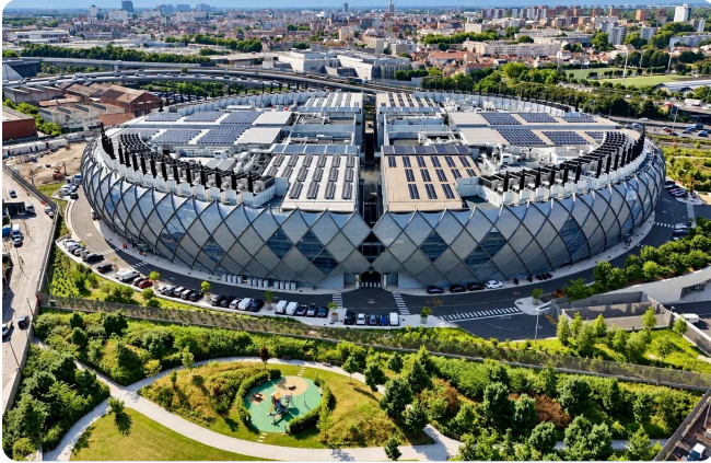
Eines der größten Rechenzentren Europas mit 72 TECS-Kühlern
