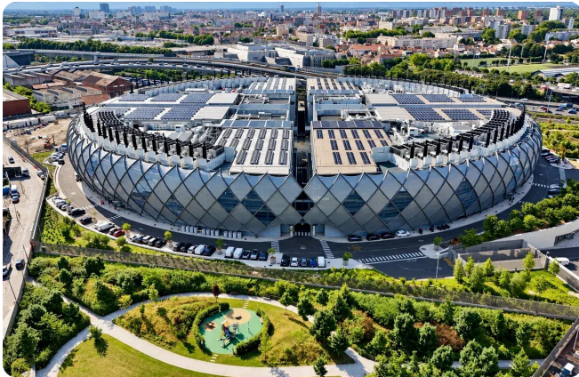
L'un des plus grands centres de données d'Europe, équipé de 72 radiateurs TECS
