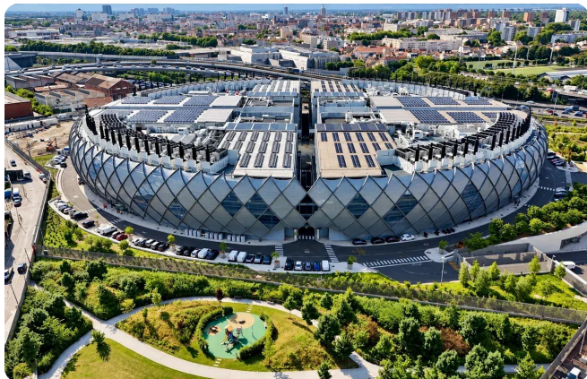
欧州最大級のデータセンターの一つに72台のTECSラジエーター
